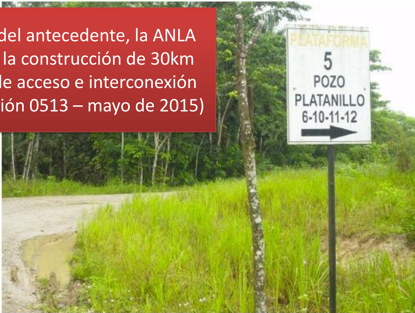
Humedal fragmentado por la construcción de la vía La Alea- La Rosa.
